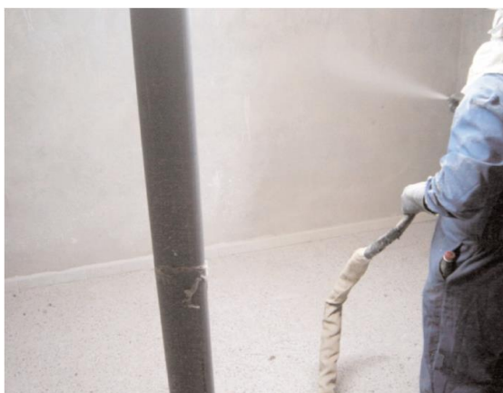
Obr. 3.27. - Průběh procesu nanášení elastomerového materiálu stříkáním
